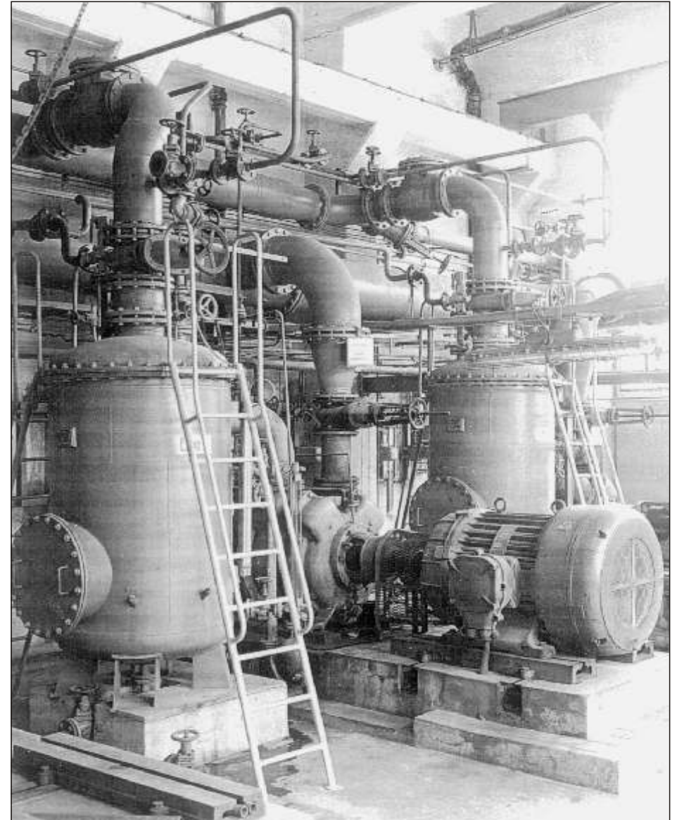
Bild 27 Acetylenverdichter I 97
