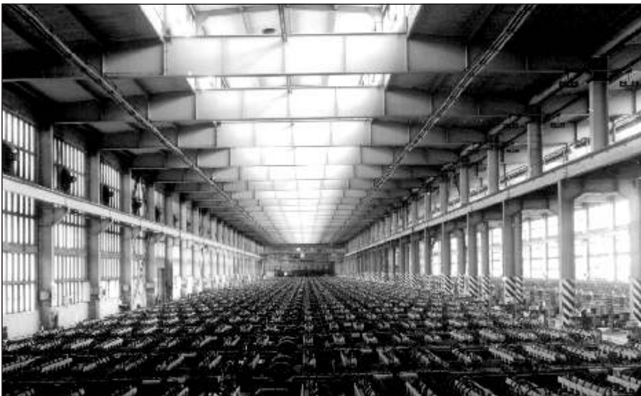
Bild 14 Der Bädersaal der Chloralkalielektrolyse im Bau L 66
