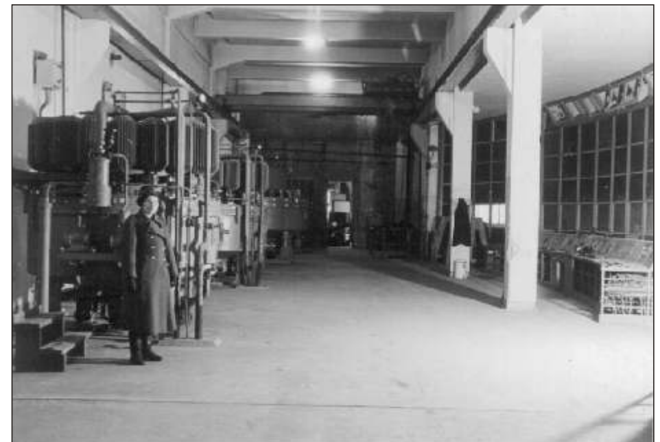
Bild 7 Hg-Dampfgleichrichter in H 56
