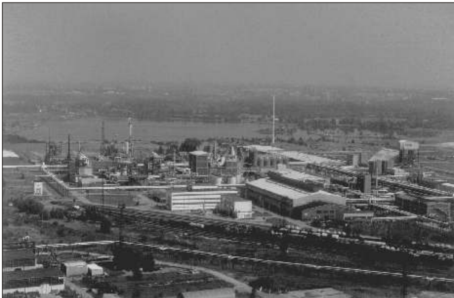
Bild 17 Blick auf die Chloralkalielektrolyse im Bau P 159
