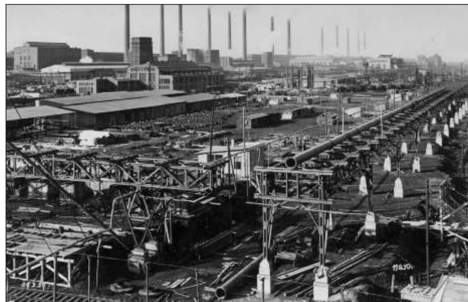
Bild 24 Aufbau der Hydrieranlagen in Leuna 1927
