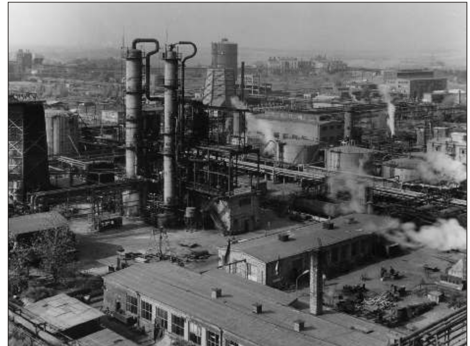
Bild 42 Rohöldestillation Ost (Bau 302)
