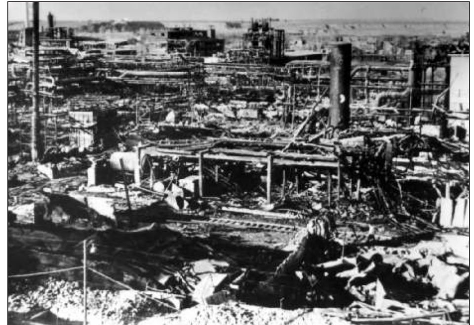
Bild 1 1945: Zerstörte Anlagen im Mineralölwerk Lützkendorf
