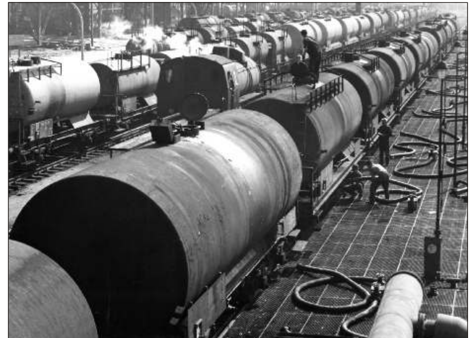
Bild 8 Kesselwagenentladung im Mineralölwerk Lützkendorf
