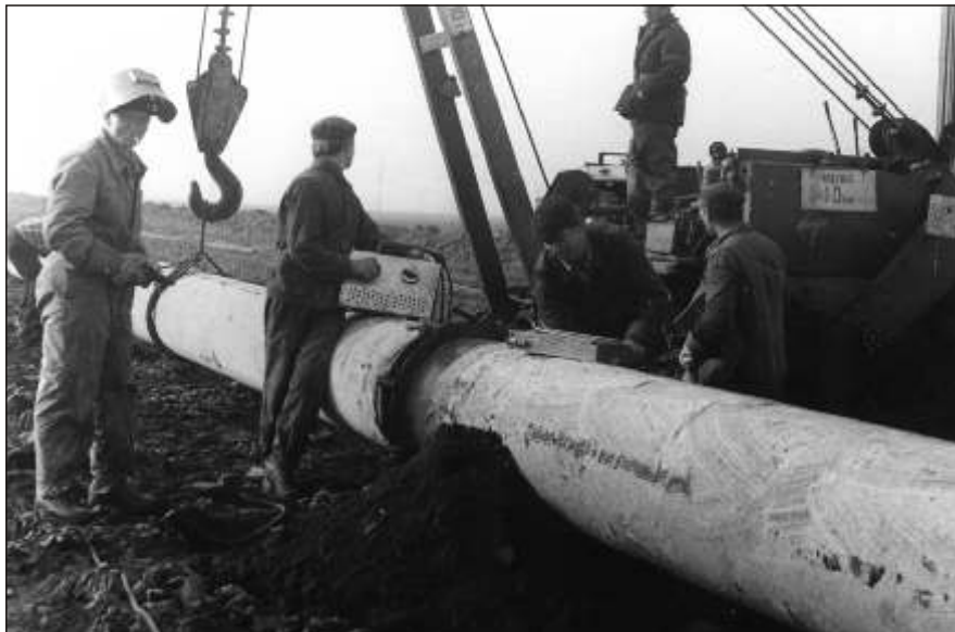
Bild 11 Bau der Erdölleitung
