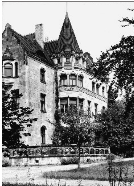
Bild 1 Halle/Saale, Neuwerk Nr. 7
