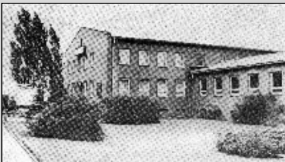
Bild 22 Sozialgebäude in Köpsen
