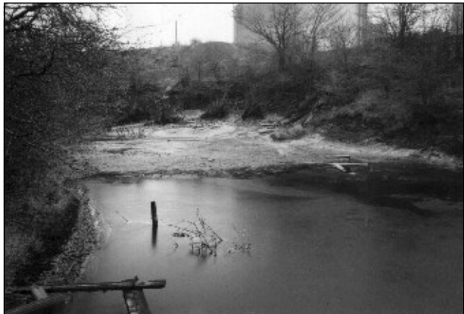
Bild 33 Zustand der Kläranlagen vor der Sanierung
