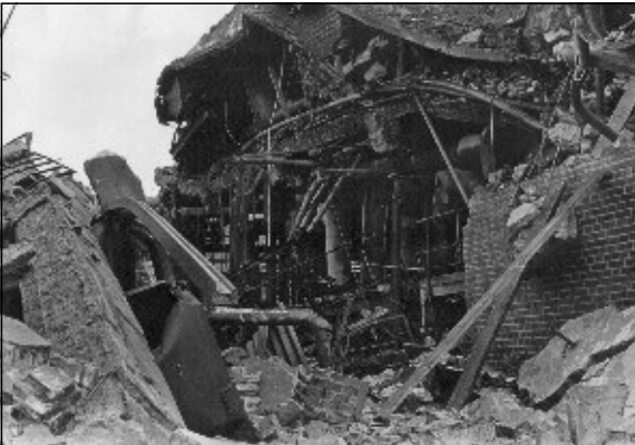
Bild 25 Nach der Explosion in der Lösungsmittelrückgewinnung Köpsen – Westseite
