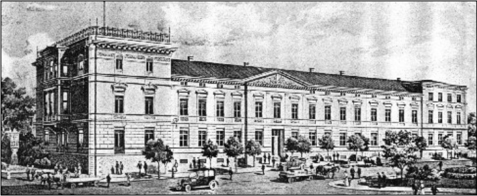
Bild 9 Wohn- und Geschäftshaus RIEBECKs in Halle, ab 1883 Hauptverwaltung der Riebeckschen Montanwerke AG
