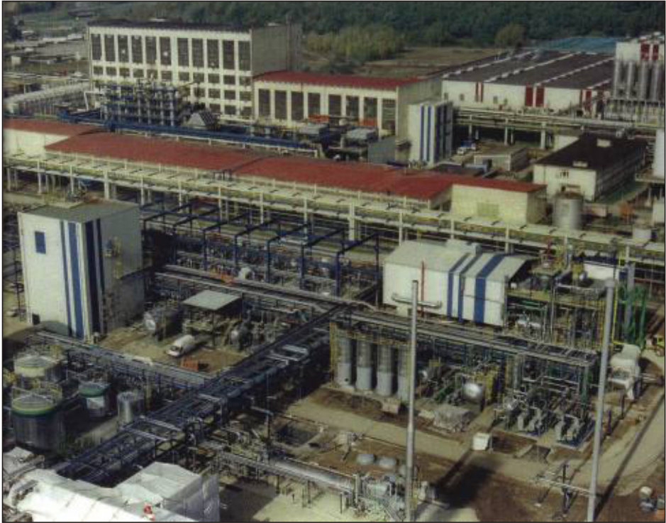
Bild 18 Blick auf die Caprolactamanlage der DOMO Caproleuna GmbH im Werksteil II des Leuna-Werkes, im Vordergrund die Anlagenteile der neuen HAS-Anlage, 1998 (vgl. mit Bildern 27 und 37 im Beitrag R. PESTER)
