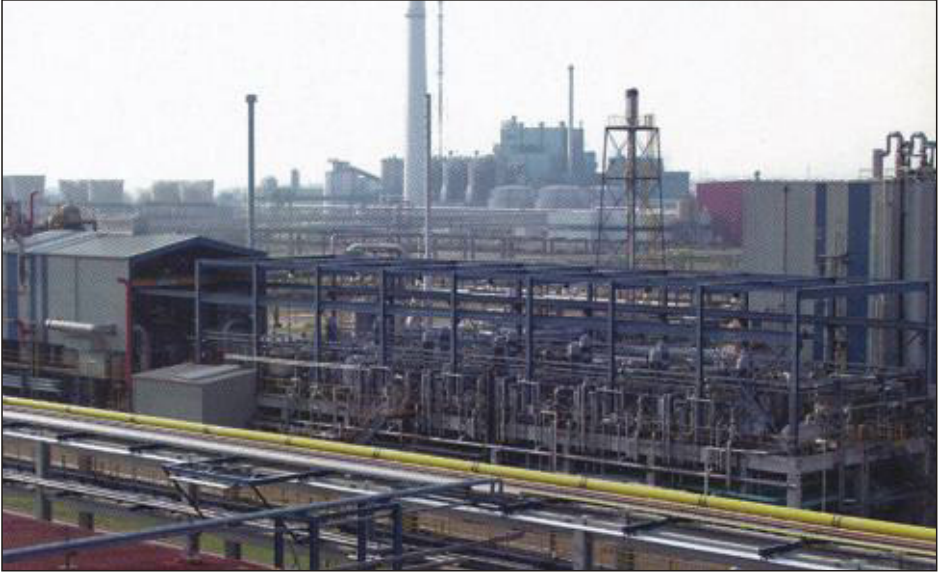
Bild 31 Neue HAS-Anlage im Werksteil II, um 1996
