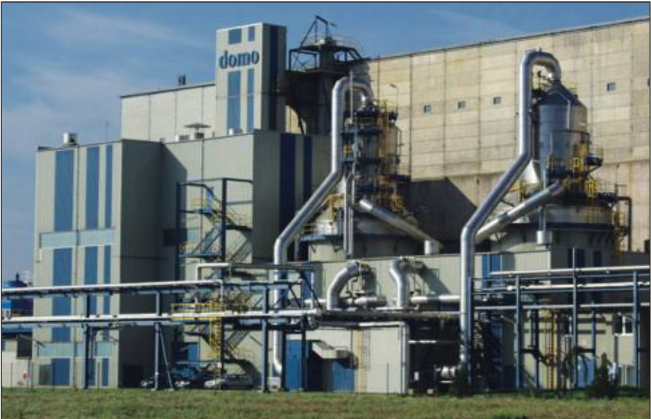
Bild 32 Anlage zur Kristallisation von Ammoniumsulfat an der Ostseite des alten Silos Bau 140 im Werksteil I, um 1996 (vgl. Bild 16, blaue Markierung)
