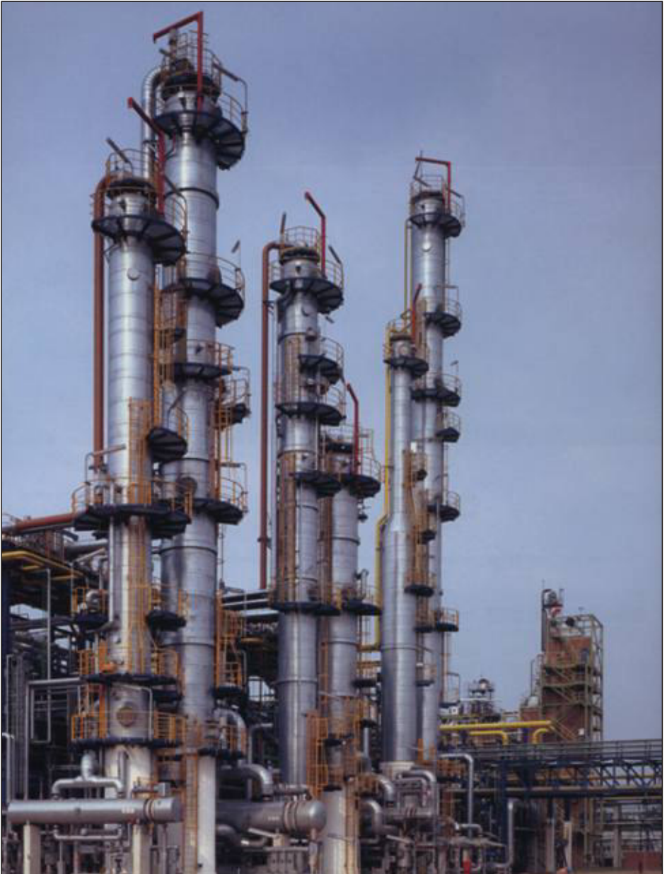
Bild 36 Cumenanlage im Werksteil II, um 2000 (vgl. Bild 28, blaues Rechteck)
