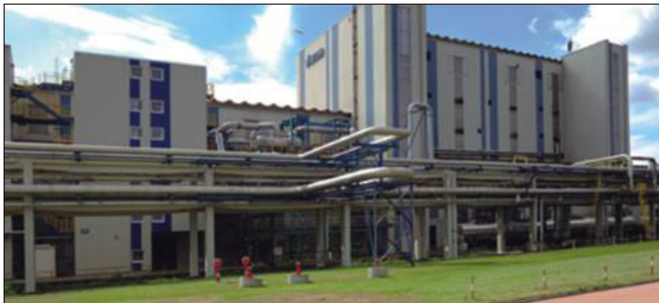
Bild 29 Cyclohexanonoxim- und Caprolactamanlage Bau 3225 im Werksteil II, Blick von Norden, um 2009
