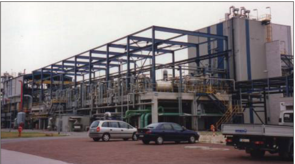
Bild 17 NO-Hydrierstraßen mit Katalysatorbau (eingehaust)
