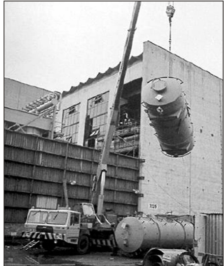
Bild 26 Der Einbau der Trennröhre für die Oximierung in die Neuanlage im Werksteil II, um 1966
