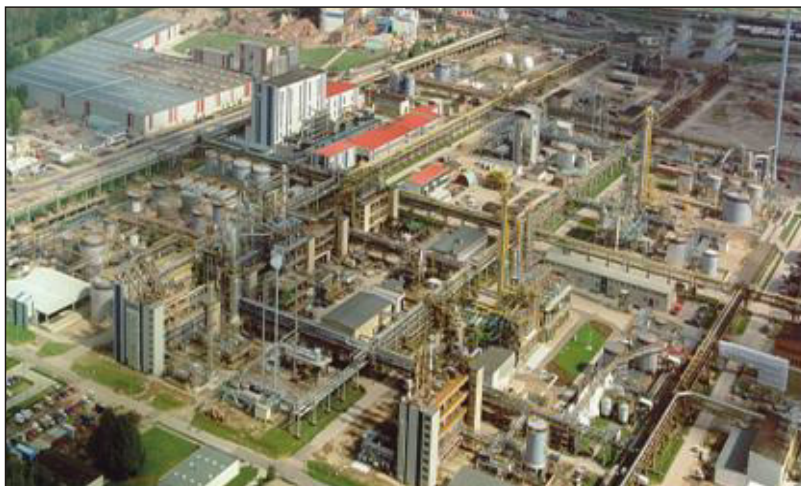
Bild 37 Blick auf die Anlagenkom- plexe der DOMO Caproleuna
