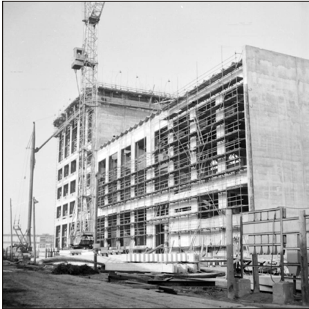
Bild 25 Caprolactamanlage im Werksteil II im Bau, um 1965
