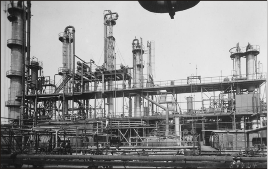
Bild 18 Cyclohexanon-Destillationsanlage im Bau 975 (1954)
