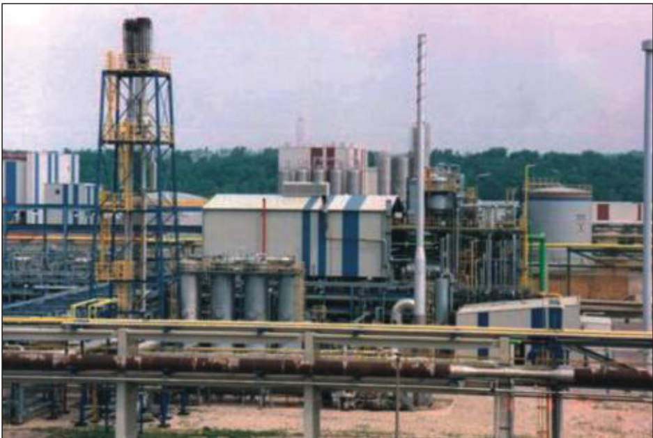
Bild 16 HAS-Anlage im Werksteil II mit Ammoniakverbrennung im eingehausten Teil
