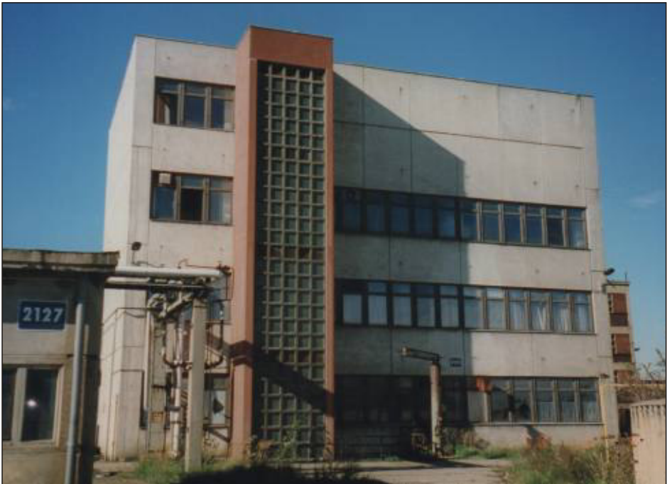
Bild 12 1986 errichteter Bau A 308 a mit zentralem Bedienstand (3. Stock), Elektro- und MSR- Werkstatt (Erdgeschoss rechts) und Sozialeinrichtungen für die Belegschaft (Erdgeschoss: Aufenthaltsraum und Toiletten, 1. Stock: Umkleide- und Baderäume, 2. Stock: Umkleideräume und Toiletten für weibliches Personal, E/MSR-Raum Steuerungstechnik und Niederspannungsverteilung)
