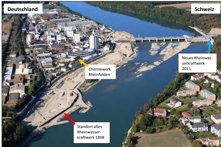
Bild 4 Die Standorte Chemiewerk und Rheinwasserkraftwerk Rheinfelden (2011, vgl. Bild 3) [7]
