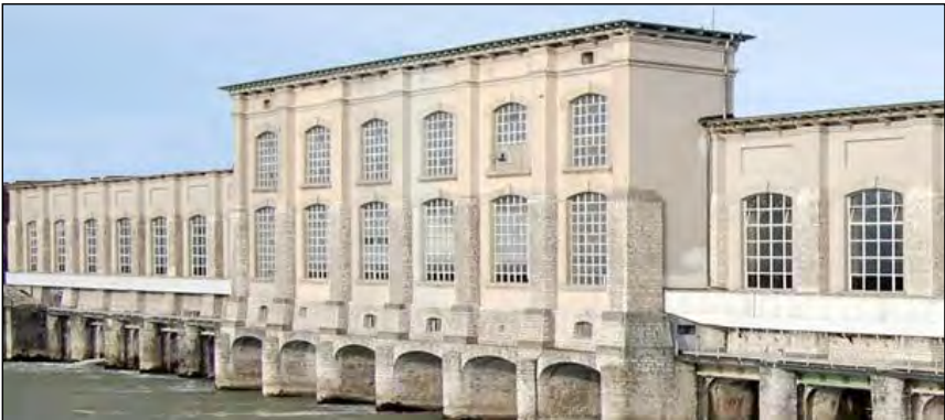
Bild 2 Das Wasserkraftwerk Rheinfelden (1898) [7]
