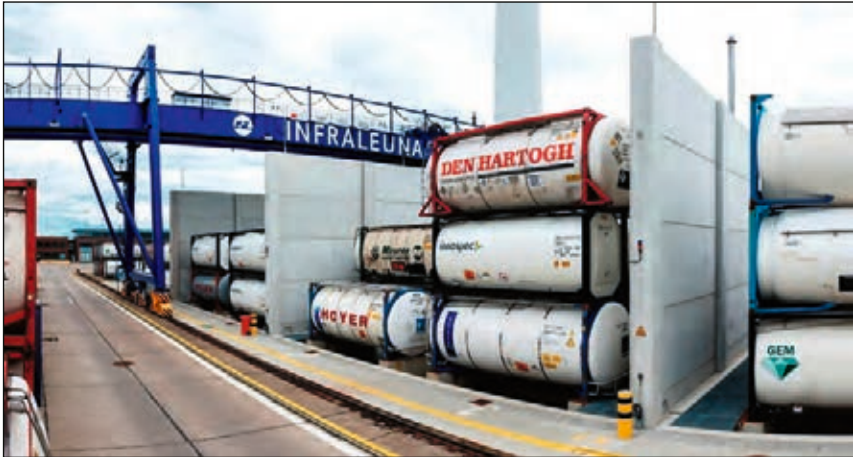
Bild 5 Das neue Containergefahrstofflager der InfraLeuna GmbH
