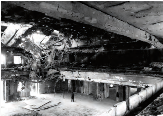
Bild 3 Bombenschäden am Feierabendhaus (Blick in den großen Saal, 15.9.1944)
